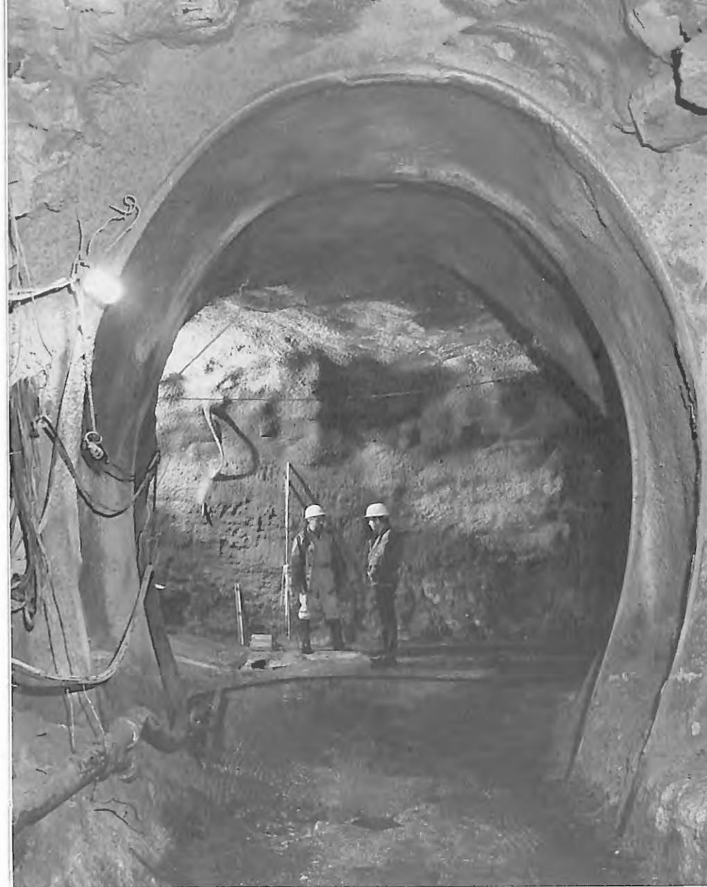
Abb. 13: Mit größter Vorsicht und höchster Präzision wurde zur ständigen Überprüfung der Sicherheit ein Kontrollstollen in die Staumauer gesprengt. Nach Fertigstellung der Beleuchtungseinrichtungen können auch Besuchergruppen hin und wieder durch das Innere des gewaltigen Bauwerks geführt werden.
