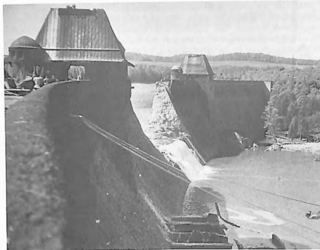
Abb. 4: Die zerstörte Sperrmauer am Tag nach der Katastrophe
