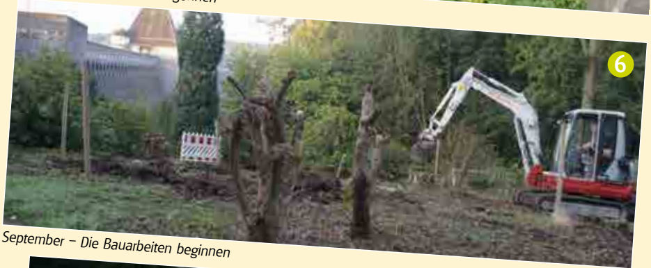
September – Das Abholzen hat begonnen
