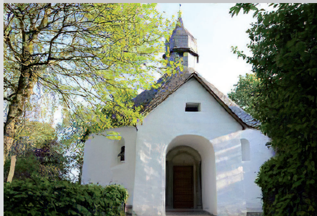
DRÜGGELTER KAPELLE IM FRÜHLING
